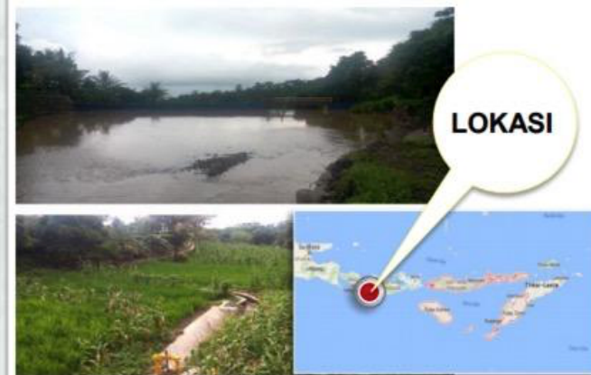
Irigasi Koak Aweng di NTB (progress fisik: 100%) 4°18'54.8"S 121°58'15"E
